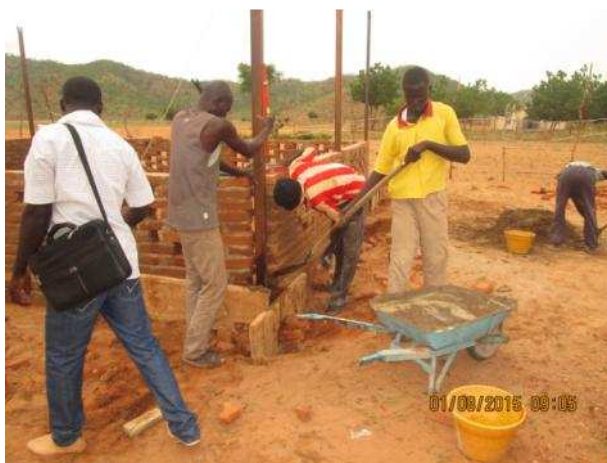
PHOTO 3 : CONSTRUCTION DU HANGAR ABRITANT LA DECORTIQUEUSE
